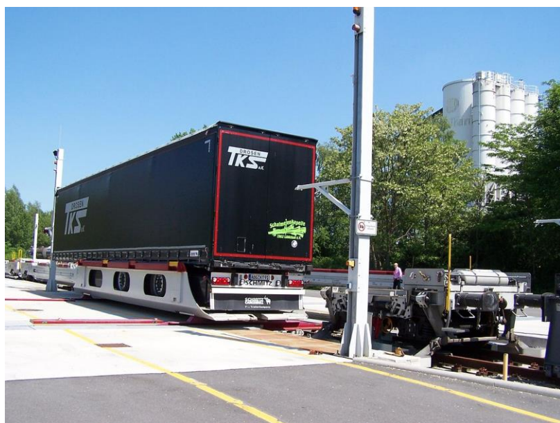
Rysunek 27. Stanowisko przeładunkowe na terminalu specjalistycznym Cargobeamer Źródło: cargobeamer.com
