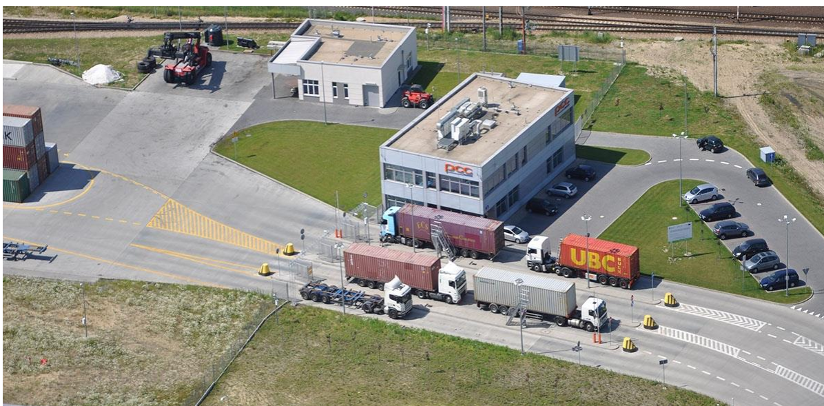
Rysunek 47. Półautomatyczna identyfikacja na bramie terminalu kombinowanego szynowo-drogowego Źródło: www.pccintermodal.pl/terminal-kutno/
