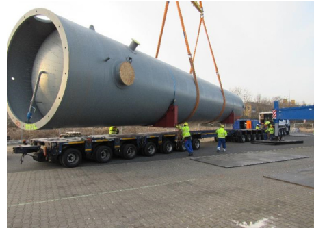
Zaladunek cylindra akumulatora ciepła w Dreźnie, 2017 Fot.:Sächsische Binnenhäfen Oberelbe GmbH
