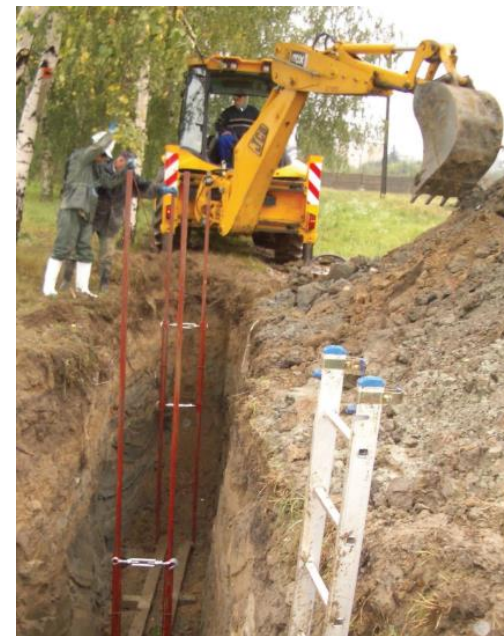
Hydrogeotechnika Sp. z oo Ścianka szczelna Remediacja.
