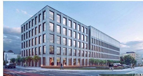
W budowie Centrum biurowe Preludium Fryderyka Chopina - GLA: 13 000 m 2
