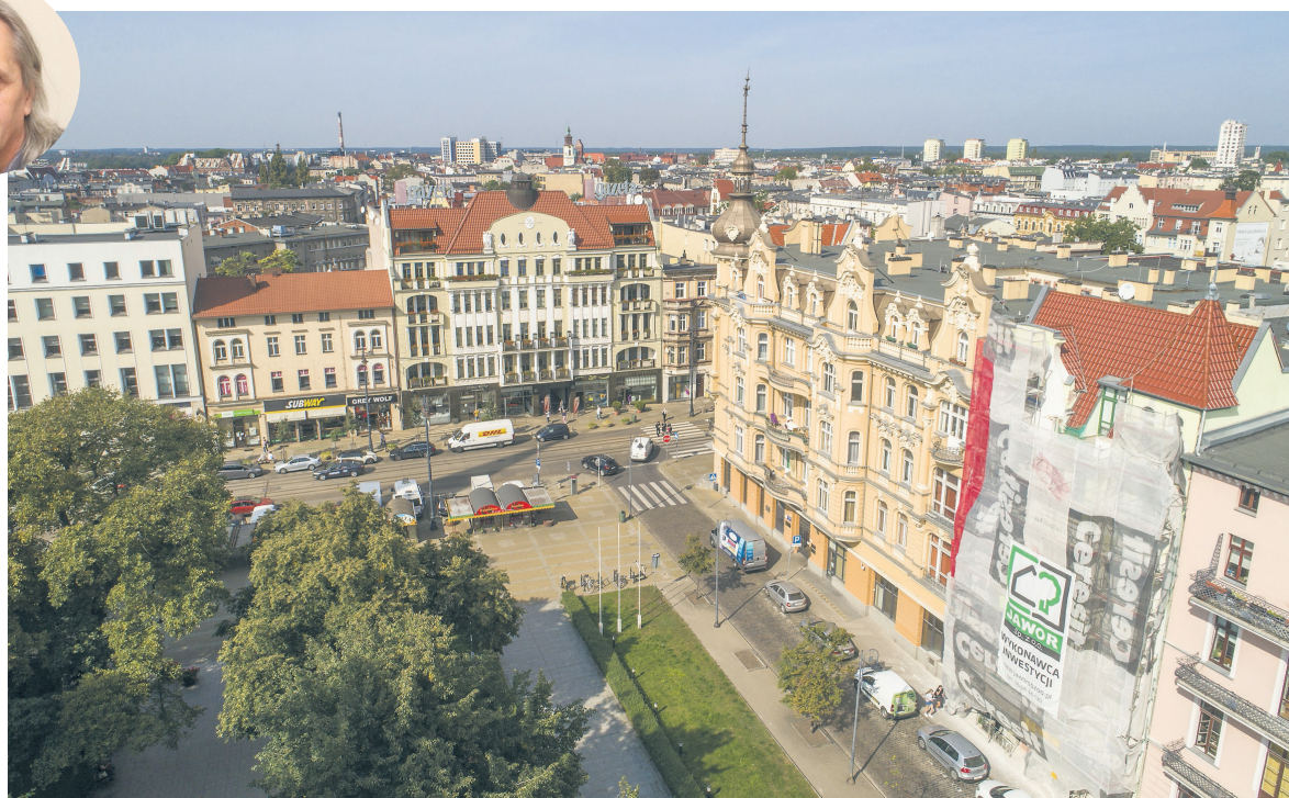
Dzięki miejskim dotacjom wypiękniło wiele gmachów w rejonie pl. Wolności. Na zdjęciu remont kamienicy z nr 3
