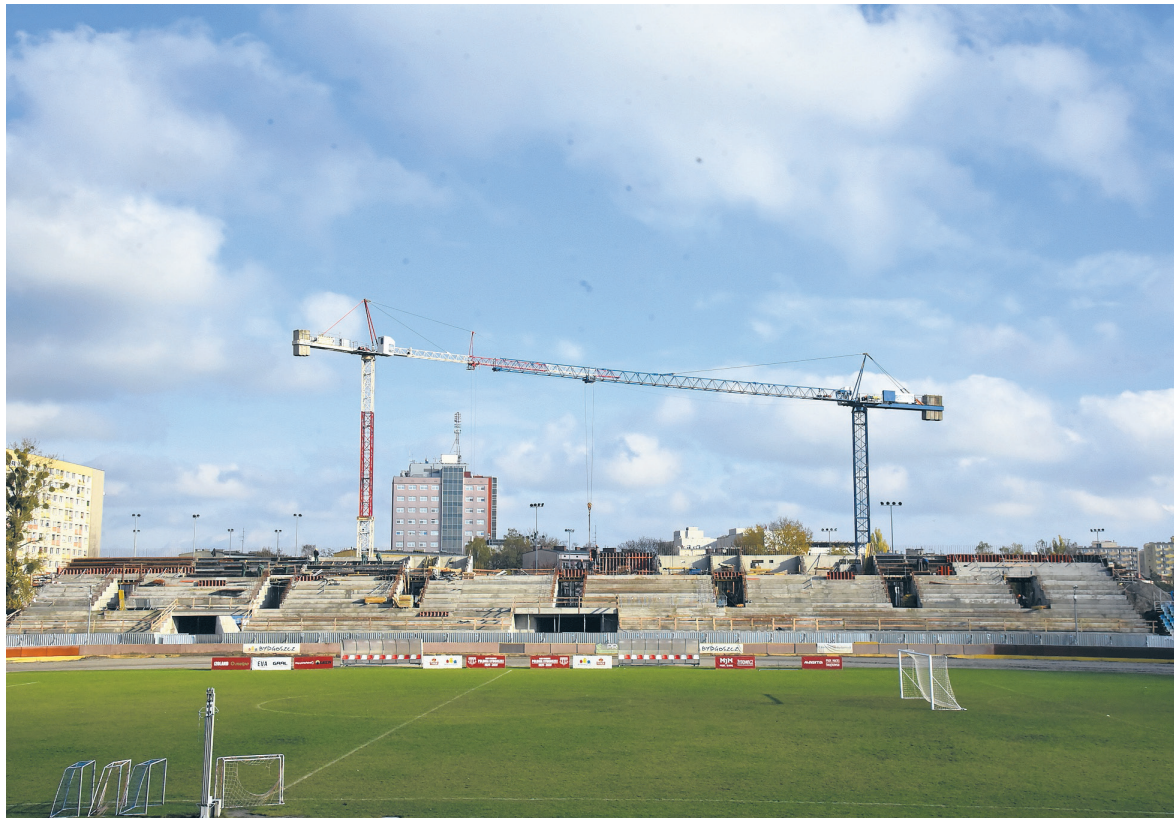
Trwa modernizacja stadionu Polonii. Inwestycja o wartości 23 mln zł będzie gotowa wiosną. Prowadzone są roboty wykończeniowe
